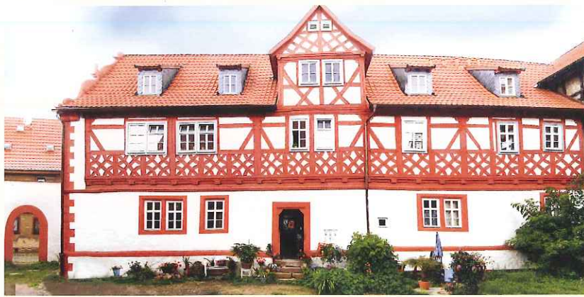
kunstvoll gestaltetes Fachwerk (Viertelkreisrauten, „Wilder Mann“). Das Innere des Hauses zieren Stuckdecken in den Formen der Renaissance.
